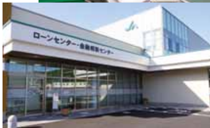
拡張された苺パッケージセンター
